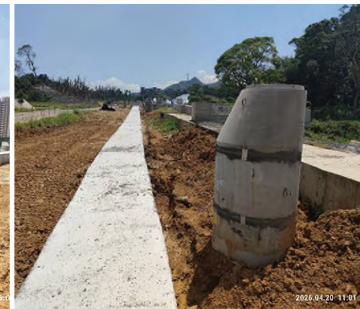
161kV管路 及污水人孔
