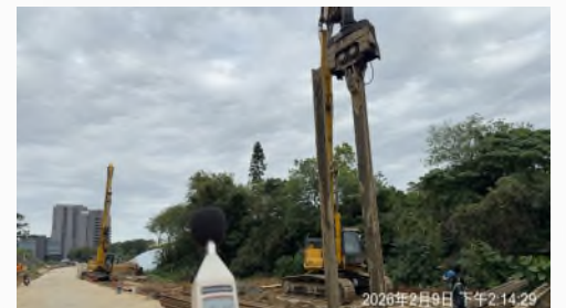
使用低噪音型施工機具
